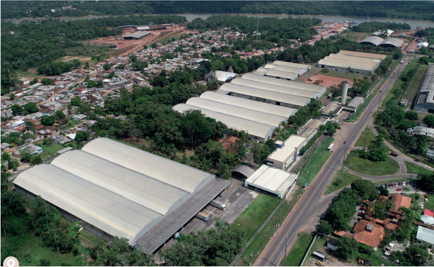
Unidade Fabril BELÉM | BELEM'S Plant | Unidad fabril BELÉM
